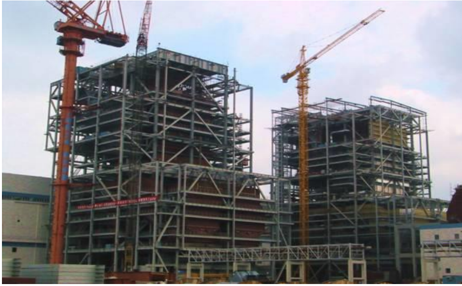
图 6: 建设中的电站锅炉
