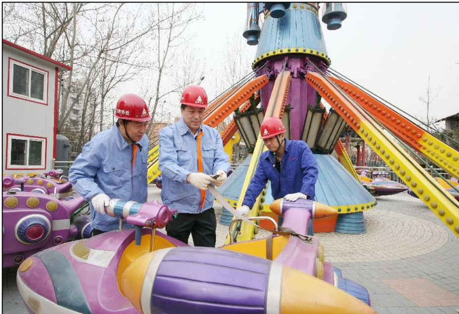
图 25：检验人员在对大型游乐设施进行检验
