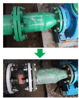
**问题点：**制氧车间2#机组预冷水泵进口无膨胀节，管道存在应力导致水泵运行时振动过大，且检修安装时因存在应力安装难度大。
